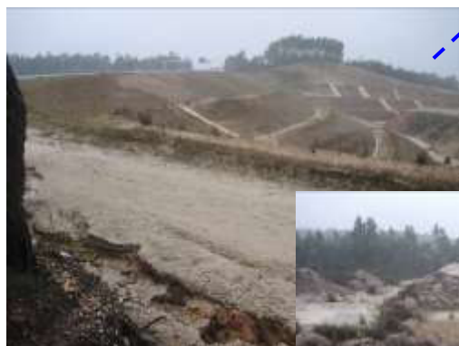
Fotografia 2 - Talude da auto-estrada.
