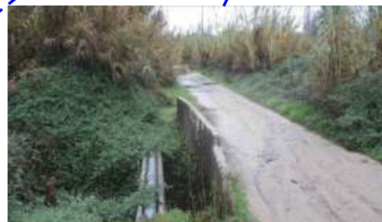
Fotografia 18 – Linha de água e caminho que atravessa a zona de várzea.
