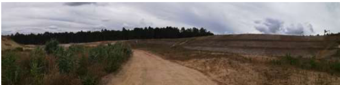
Figura 157 - Vista a partir da Mina da Faleca em direção ao talude sudoeste acima do qual se implanta o acesso ao IC2.
