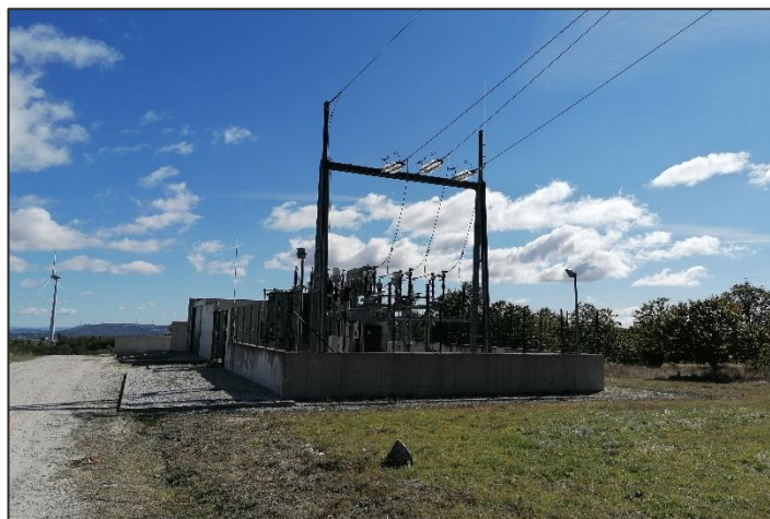
Fotografia 2 – Edifício de comando existente
