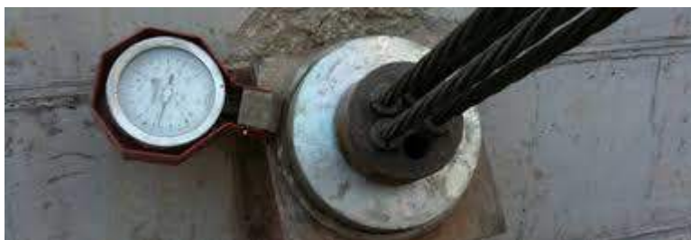
Figura 2.14 – Cabeça de ancoragem com célula de carga
