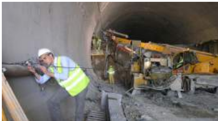
b) Medição de convergência com convergenciômetro
