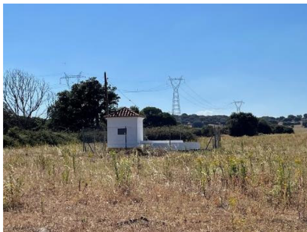
Fotografia 6.22 – Poço presente no setor C1
