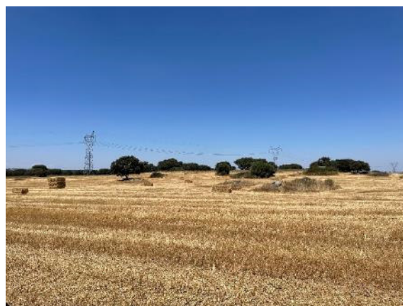
Fotografia 6.62 – Infraestruturas de produção de energia (Linhas de Muito Alta Tensão)
