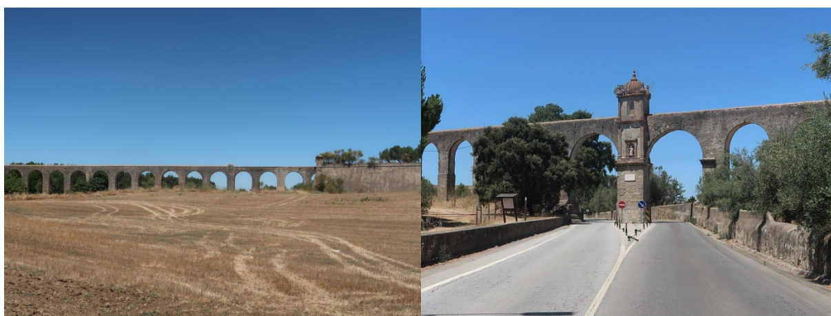
Fotografia 6.85 – Aspetos do Aqueduto da Prata, na chegada às muralhas de Évora e sobrepassagem da estrada para Arraiolos
