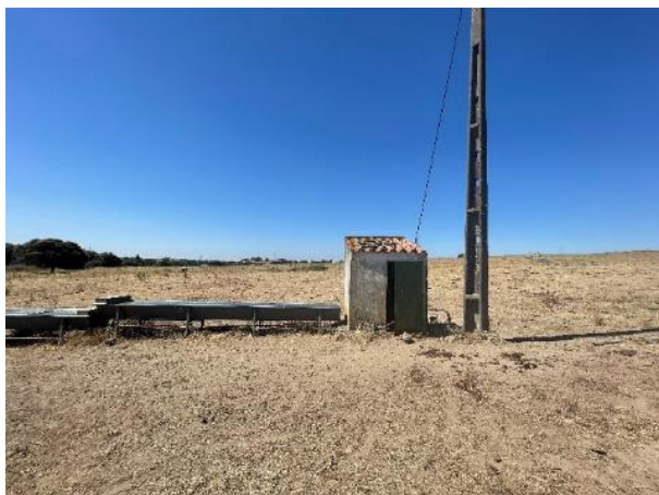
Fotografia 6.21 – Furo vertical presente no setor B1
