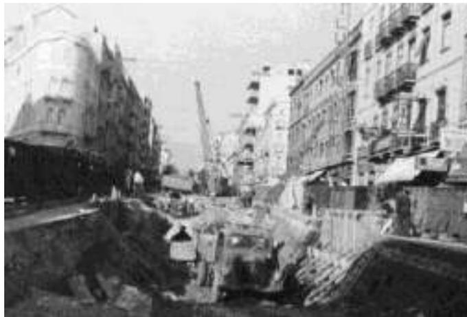
Figura 6.21 – Foto das obras de construção do metropolitano de Lisboa, na Avenida Almirante Reis. Notar o caneiro existente na espalda esquerda da trincheira
