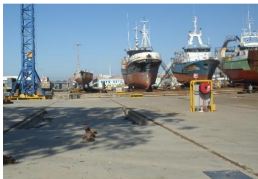
Figura 4: Carreira de encalhe de navio – plano horizontal.
