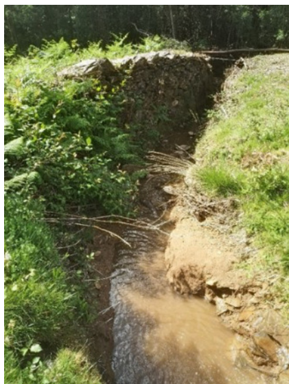
Foto 3: Canal construído em pedra para condução de águas
