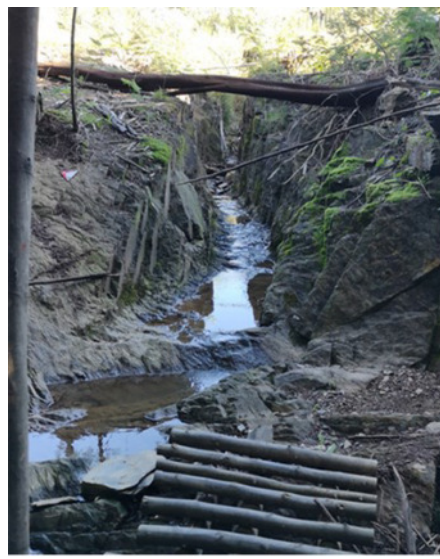
Foto 4: Canal escavado para condução de águas
