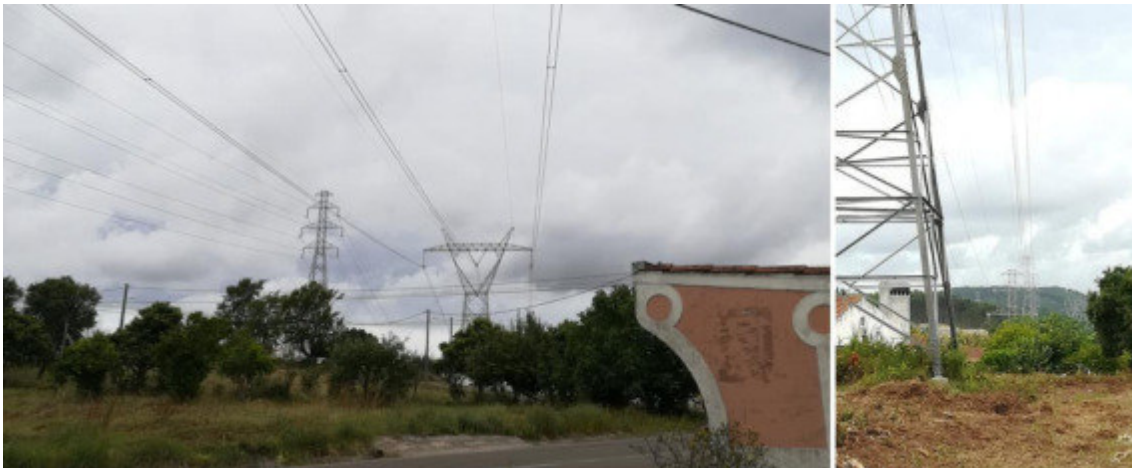
Figura 10 Vista da rede elétrica de AT na envolvente de Abuxanas (esq.) e da sua projeção sobre a paisagem a norte (dir.).
