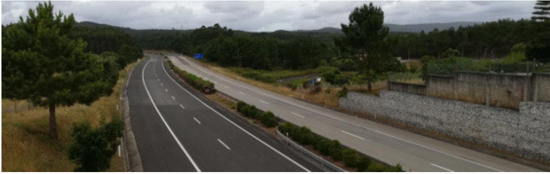
Figura 9 Vista da A15 a partir do viaduto a oeste de Vale de Óbidos.
