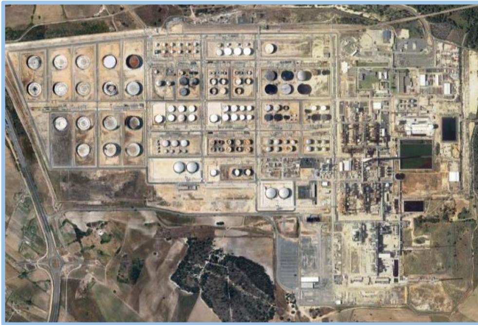
Figura 2- Vista satélite atual da Refinaria de Sines
