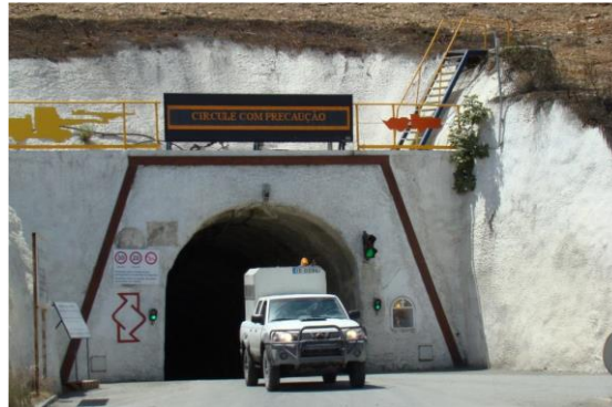
Fotografia 4.1 - Acesso à mina para pessoal e equipamento
