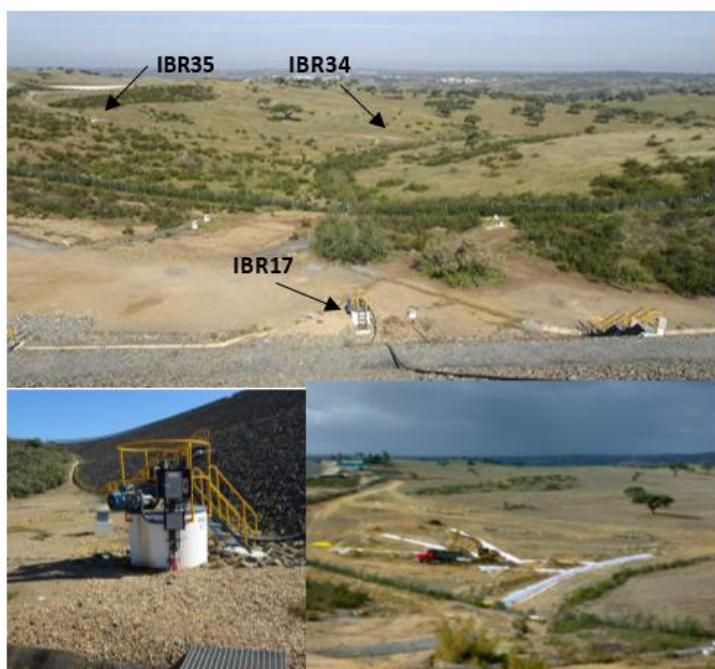
Em cima: Vista geral a partir do coroamento da IRCL de parte da rede de IBR. Junto ao pé de talude observa-se o IBR17 e na zona mais afastada da IRCL os IBR34 e IBR35. À esquerda: Imagem do IBR17; À direita: Construção das valas de drenagem coletadas pelo IBR34
