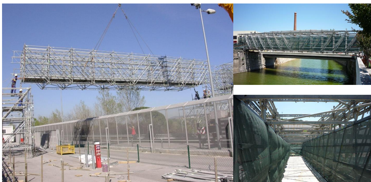
Figura 3 – Exemplos de aplicação de Passadiços Pedonais provisórios
