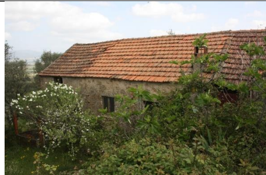
Fig.3. Edifício de habitação rural (O- E).
