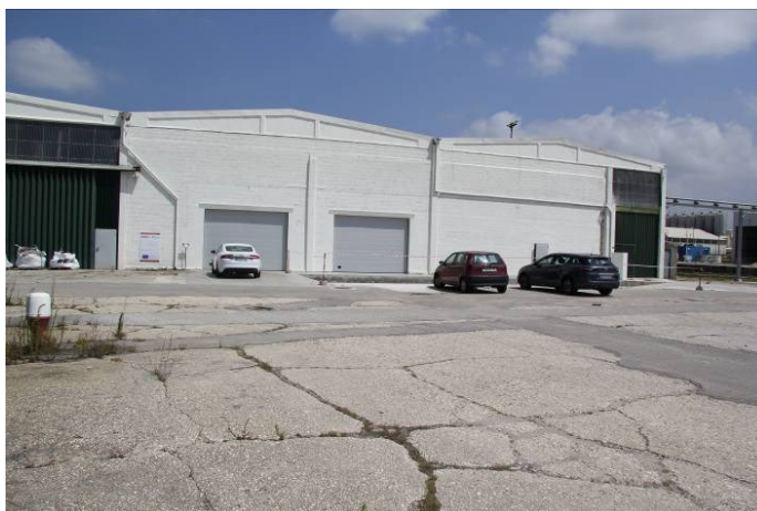
Figura 5.38 – Fachada frontal do edifício, onde se irá implantar o projeto.
