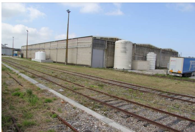
Figura 5.39 – Vista da traseira e parte nascente do edifício.
