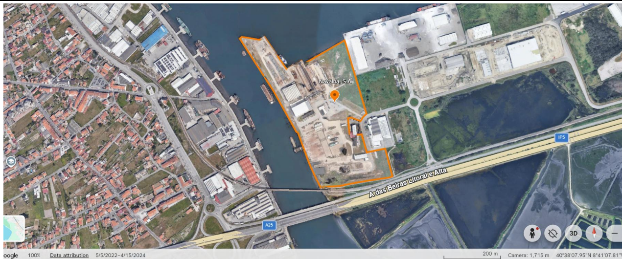
Figura 1: Implantação do estaleiro da Navalria, S.A.
