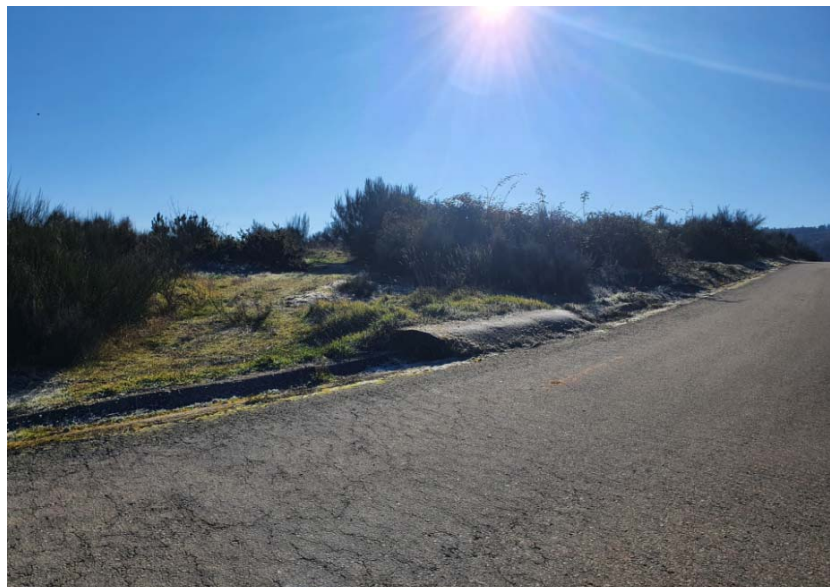
Fotografia D4.19 - Estaleiro 3 (acesso à parcela)
