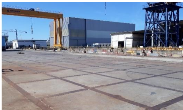
Figura 5 – Área de apoio à Doca Seca.
