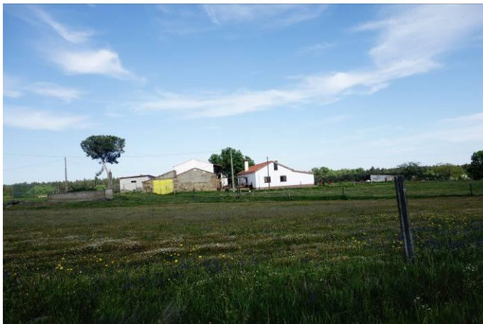
Fotografia 1 - Vista da habitação a partir do local de implantação do apoio P14.
