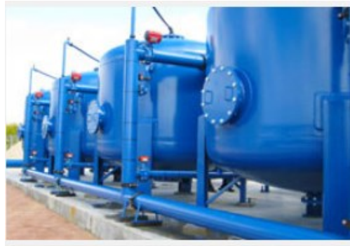
Figura 7 – Figura ilustrativa dos Filtros rápidos Multicamada
