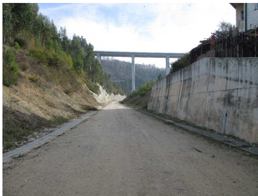
Foto 1 – Vista atual do canal suburbano do Metrobus no troço Alto S. João / Serpins, onde decorreram já obras do projeto do metro ligeiro e que implica agora adaptação ao sistema de Metrobus (DCAPE do projeto de alterações aprovado em fevereiro de 2019)
