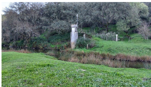
Foto 5.19 – Local (19) estação hidrométrica na zona de implantação da futura barragem do Pisão.
