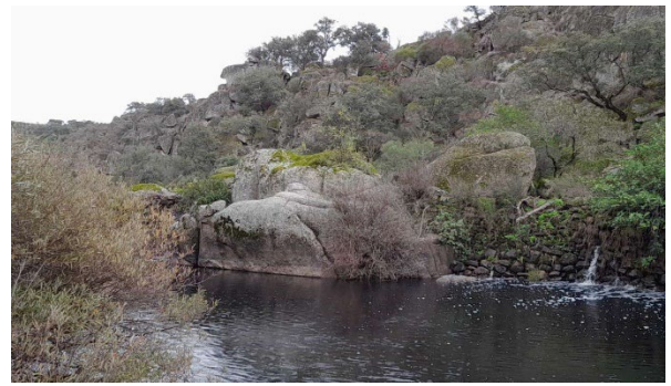
Foto 5.10 – Local (10) montante da ponte da EM 524.
