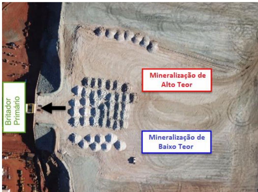
Figura II.101 - Vista aérea da disposição do stock de mineralização bruta.
