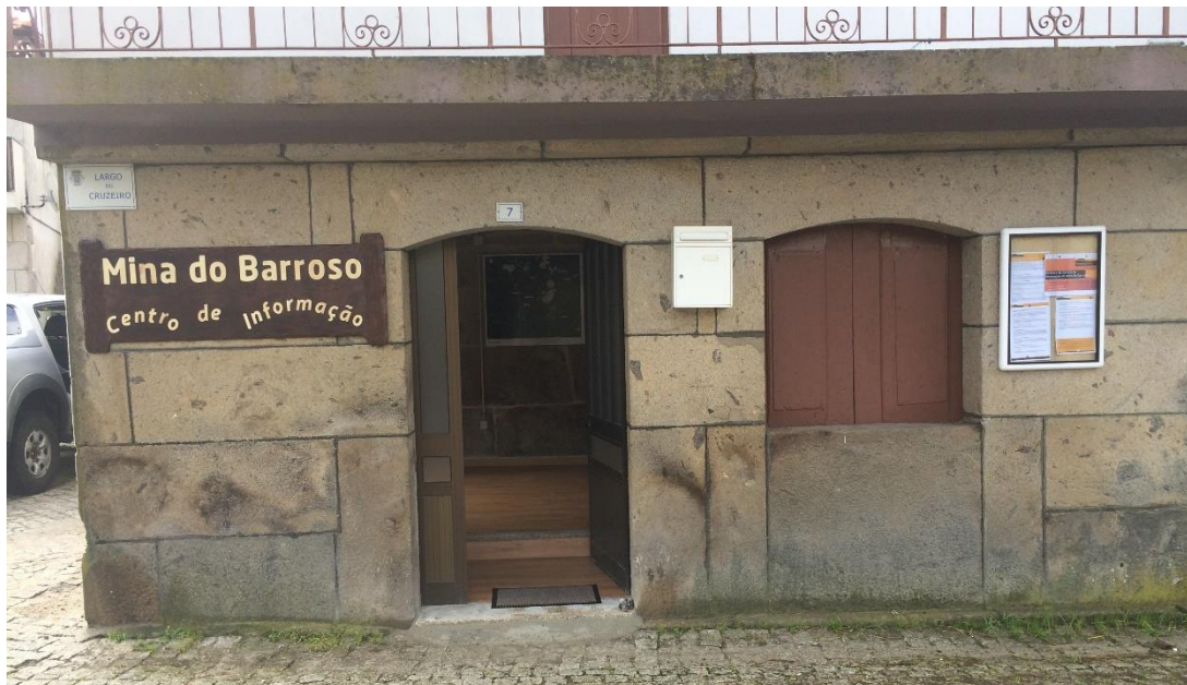
Figura II.35 - Centro de Informação da Mina do Barroso
