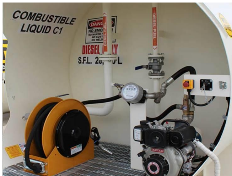
Figura II.155 - Exemplo de uma área de abastecimento de combustível.
