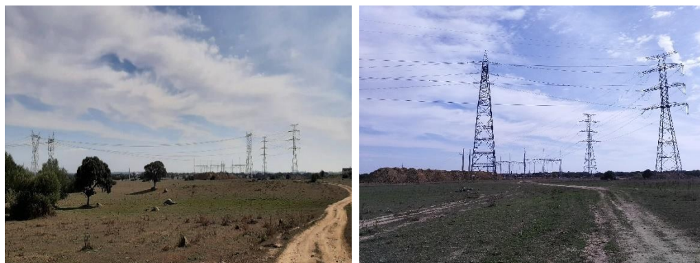
Fotografia 4.16 – Ocupação do solo no Corredor de estudo da linha elétrica: infraestruturas de produção de energia não renovável – Subestação de Divor e Linhas Elétricas, a 400 kV
