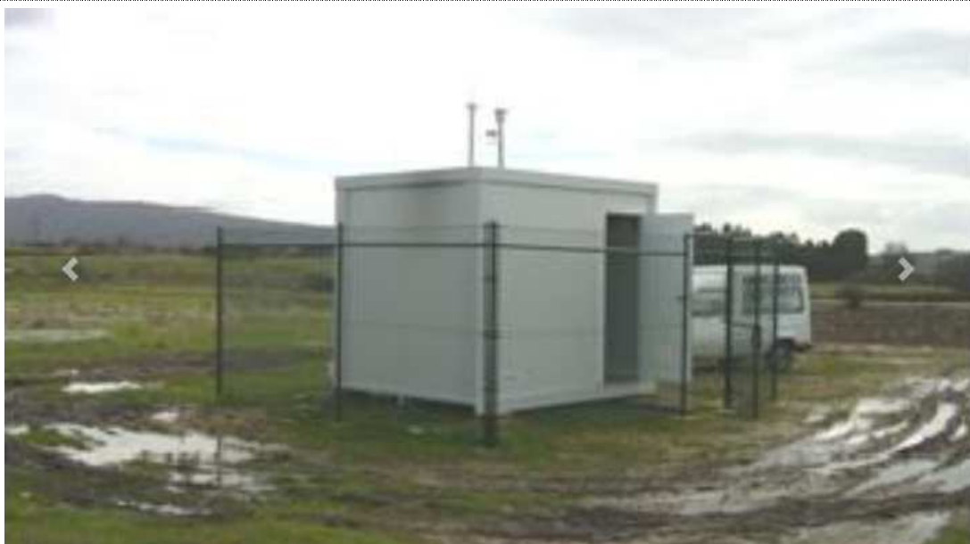
Figura 4.156 – Estação de Monitorização da Qualidade do Ar – Fundão
