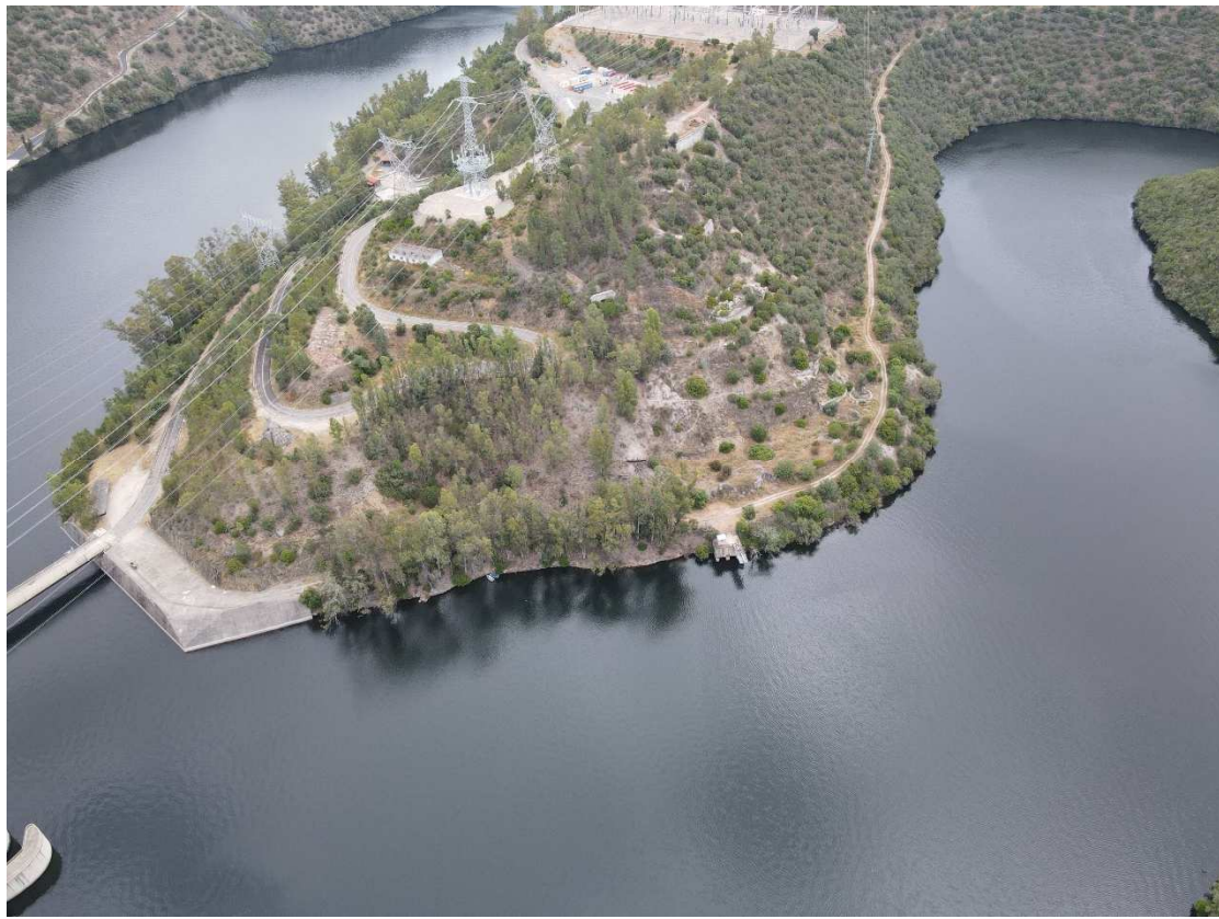
Figura 6.8 – Vista panorâmica do lado espanhol nomeadamente da via existente EX-375
