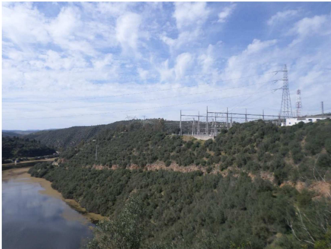
Figura 3.13 – Aspeto da Encosta onde será inserida a obra ponte – Lado Espanhol
