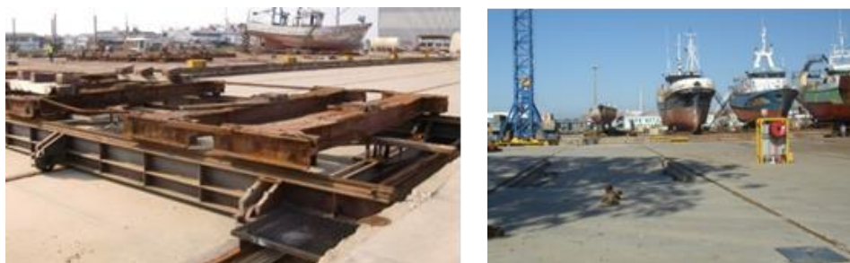
Figura 4.2- Plano horizontal – carro transfer e carreira de encalhe de navio, respetivamente.
