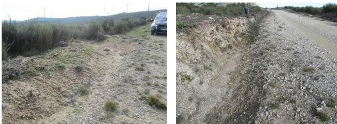
Fotografias 4.7 4.8 – Exemplo de valetas sem revestimento, observando-se à esquerda como é efetuado o encaminhamento do escoamento para a linha de água mais próxima.
