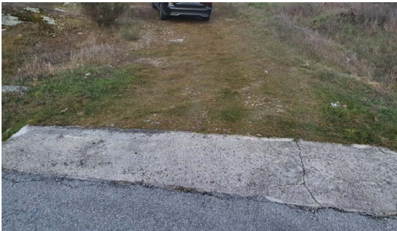
Fotografia C.7 - Visita de Campo - Estaleiro 2 - Caminho de acesso
