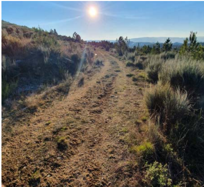
Fotografia C.3 - Visita de Campo – Acesso ao estaleiro 1 (cont.)
