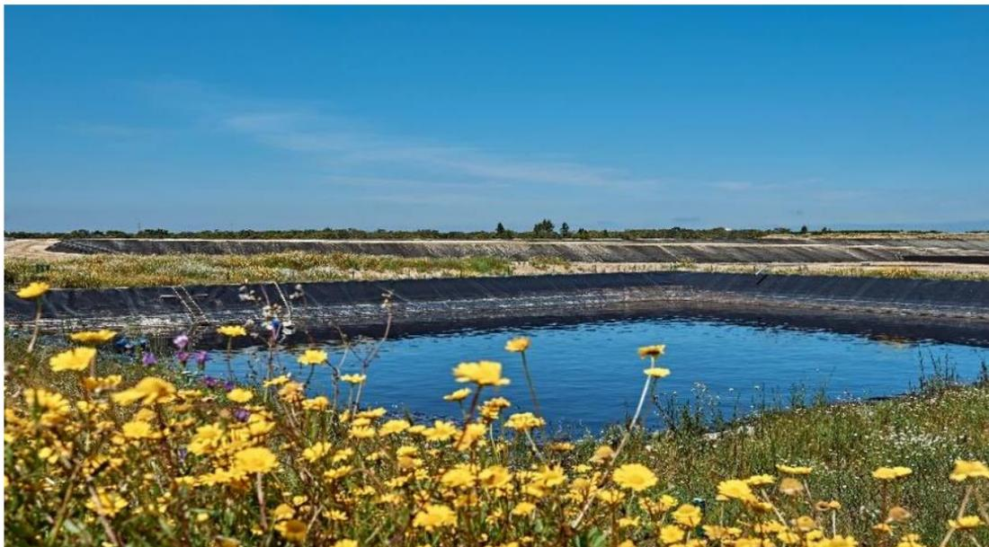
Figura 14 - Bacia de armazenamento de lixiviados
