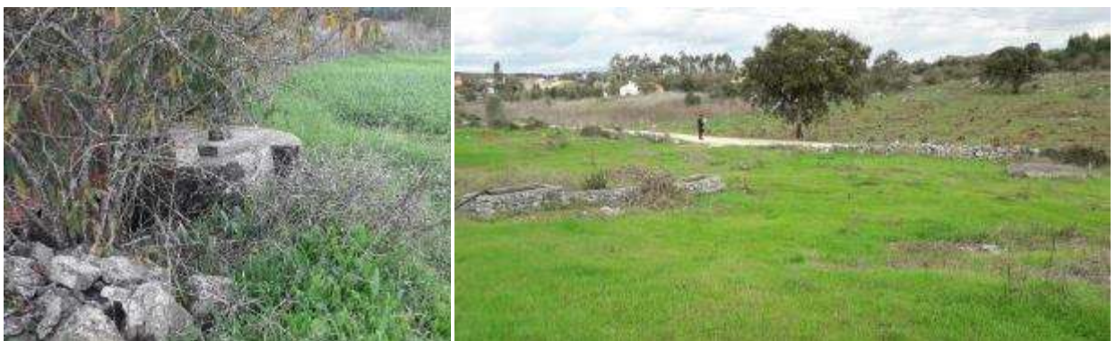
Figura 89. Poços existentes no local de intervenção
