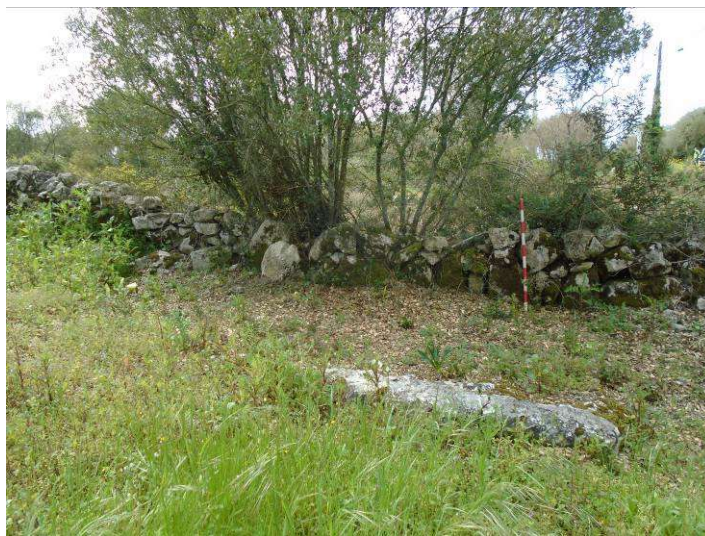
Figura 167. Rio Seco 4 - Muro
