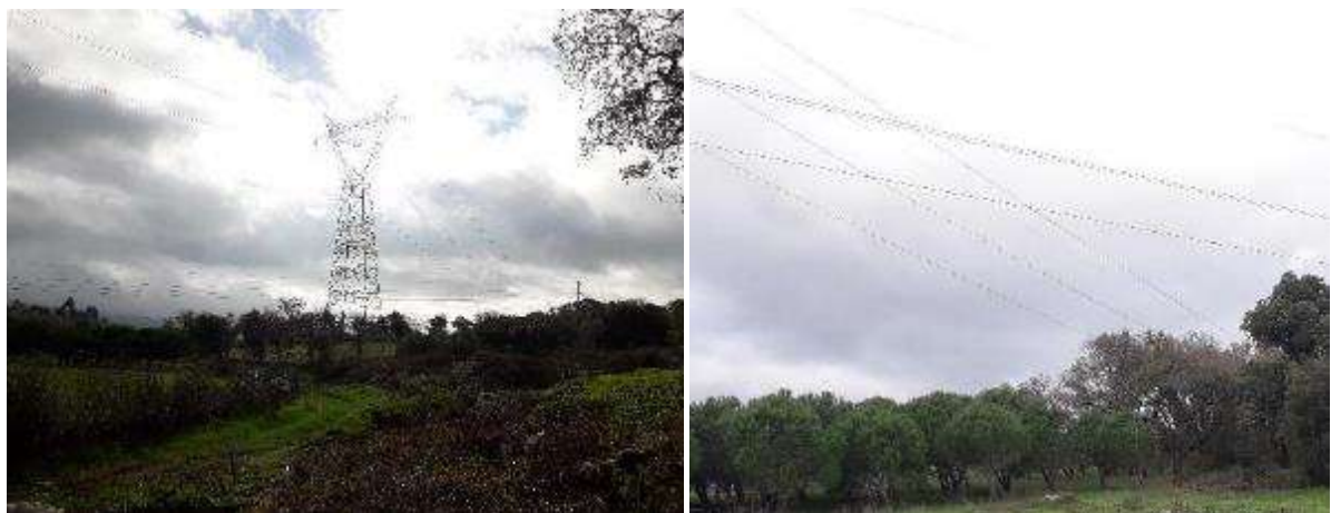
Figura 73. Rede aérea de transporte de energia que atravessa o local
