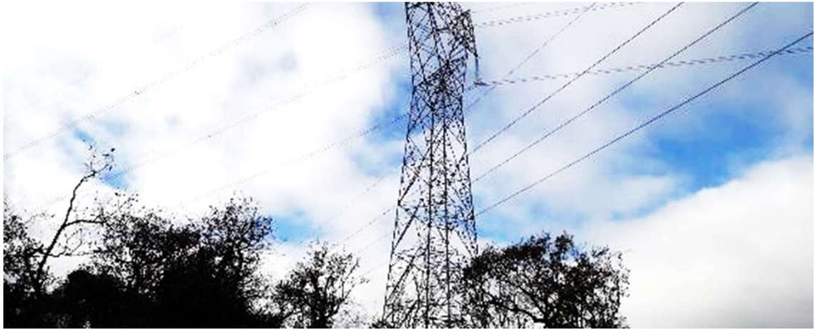
Figura 110. Estrutura de transporte de eletricidade na proximidade da zona de intervenção
