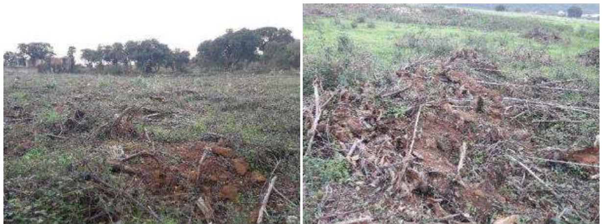
Figura 57. Solos no local de instalação do projeto
