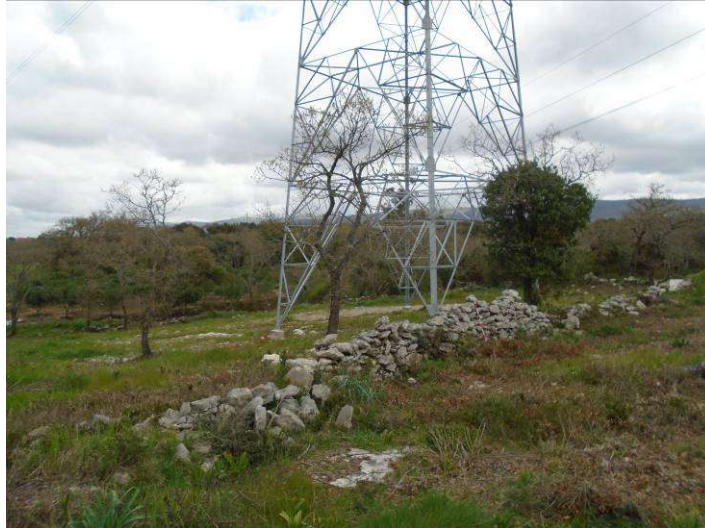
Figura 166. Rio Seco 3 - Muro
