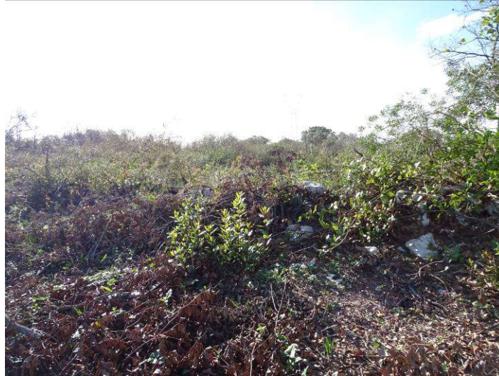
Figura 161. Rio Seco 16 - Muro
