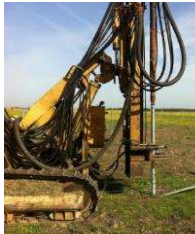
Figura 143. Sistema de aplicação das estacas (suportes das mesas), por pressão
