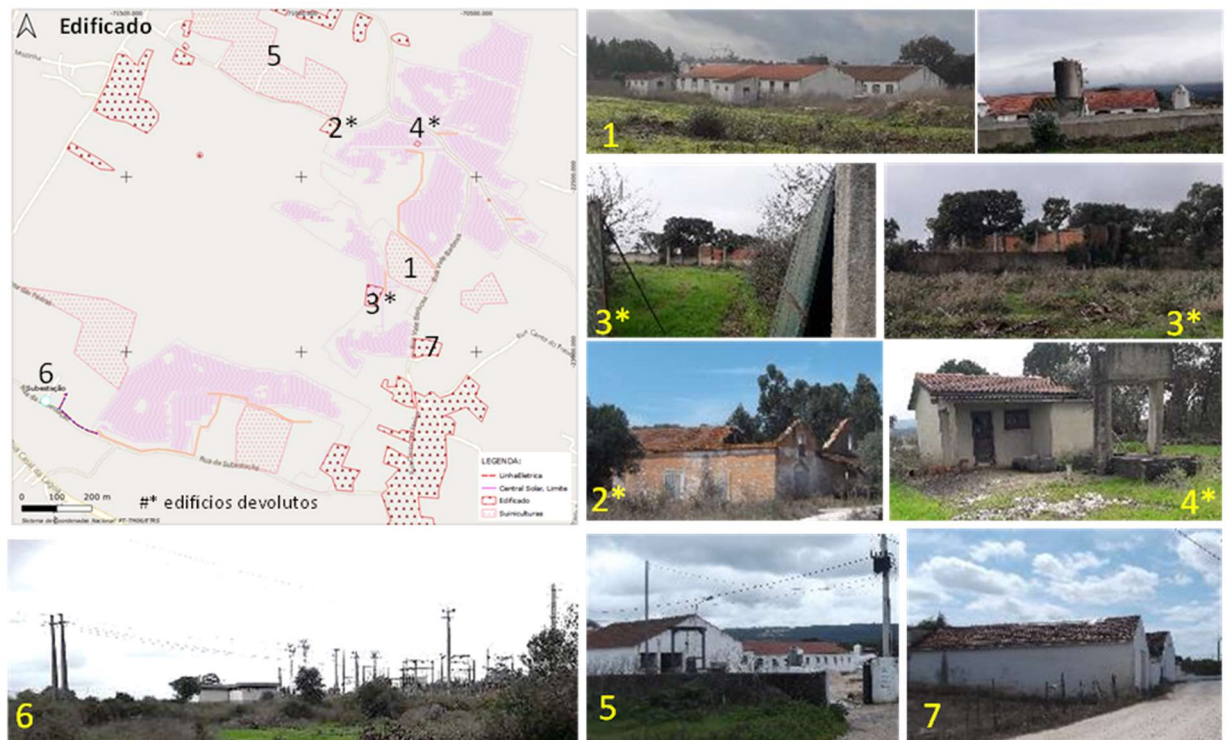
Figura 74. Edificado existente no local de intervenção, e envolvente próxima
