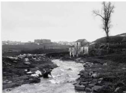
Ponte Taruço vista de montante para jusante
