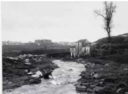
Ponte Tarujo vista de montante para jusante
