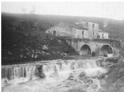
Ponte Taruço vista de jusante-montante
