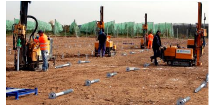
Perfuração do solo para execução da fundação da estrutura
