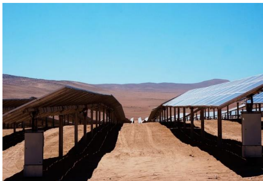
Figuras 3 e 4 – Exemplo de módulos fotovoltaicos que acompanham a morfologia do terreno
