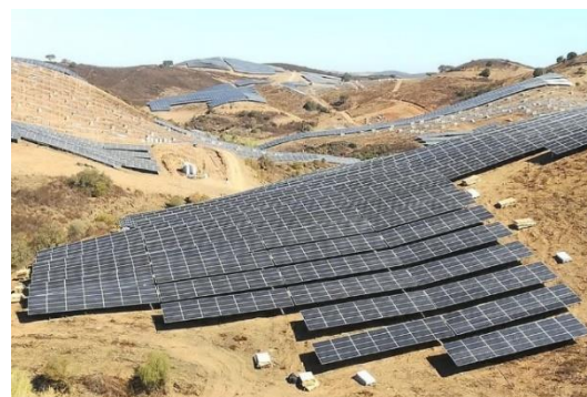
Figuras 3 e 4 – Exemplo de módulos fotovoltaicos que acompanham a morfologia do terreno
