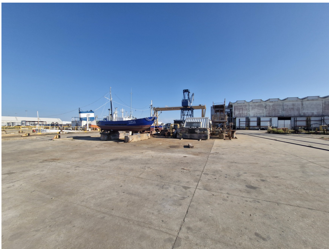
Fot. 1 e 2 – Vista geral de um conjunto de áreas a norte, onde serão desenvolvidas tarefas relacionadas com a reciclagem.
