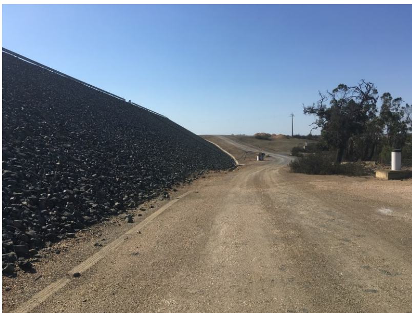
Fotografia 14 - Área de implantação do traçado da Linha Elétrica subterrânea, junto ao limite da IRCL, na vertente NE.
