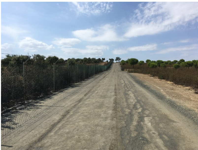
Fotografia 19 – Acesso à Área A4 de deposição temporária de materiais para aterro e cobertura.
