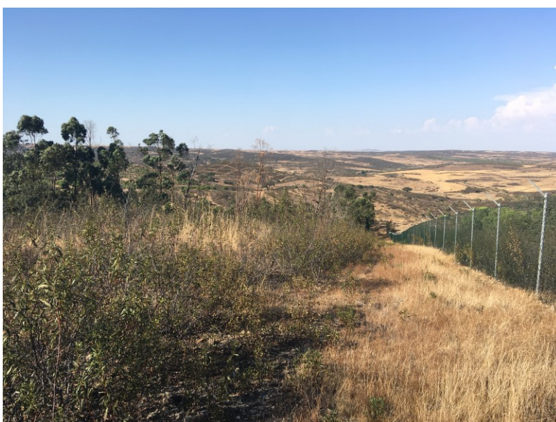
Fotografia 8 – Traçado do Canal de drenagem do RC-N.
