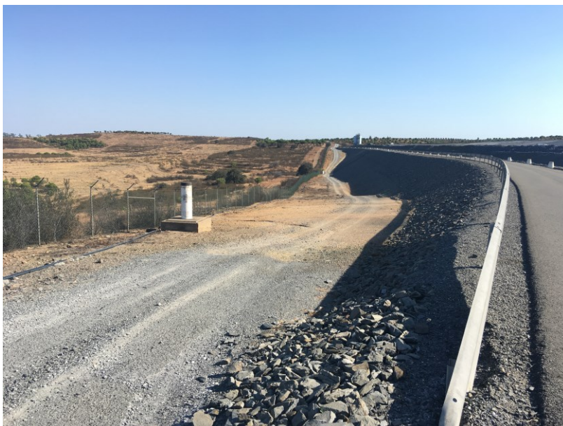
Fotografia 13 - Área de implantação do traçado da Linha Elétrica subterrânea, junto ao limite da IRCL, na vertente SE.
