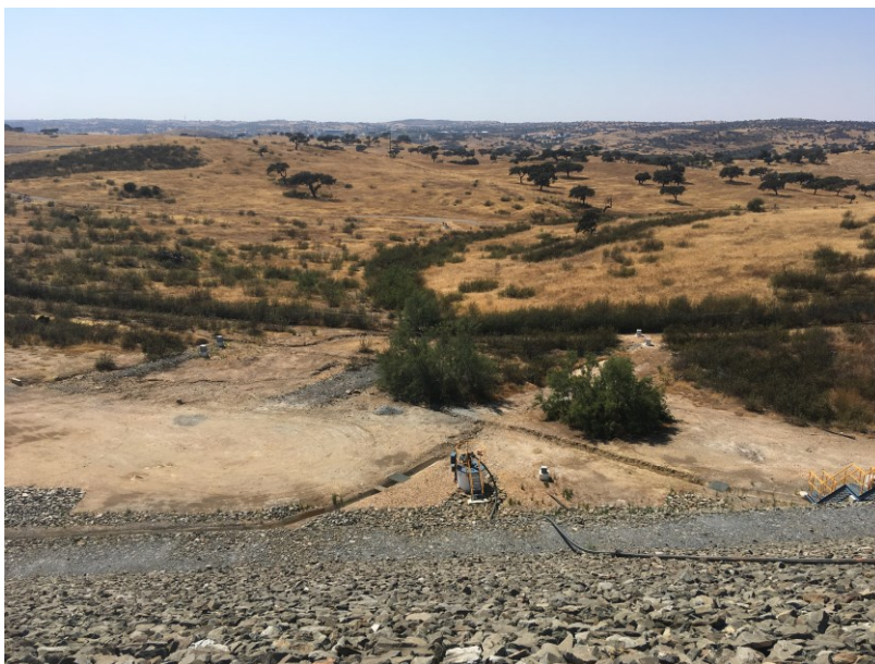
Fotografia 11 – Vista geral sobre área do novo canal de drenagem (a Este do RC-NW).
