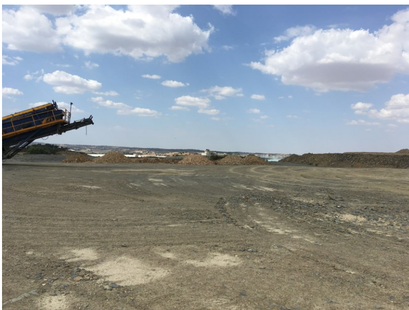
Fotografia 16 - Área de implantação da Área A2 de deposição temporária de materiais para aterro e cobertura
