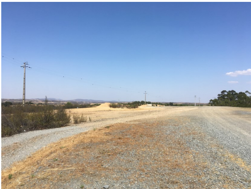
Fotografia 3 - Área de implantação do Estaleiro 1.
