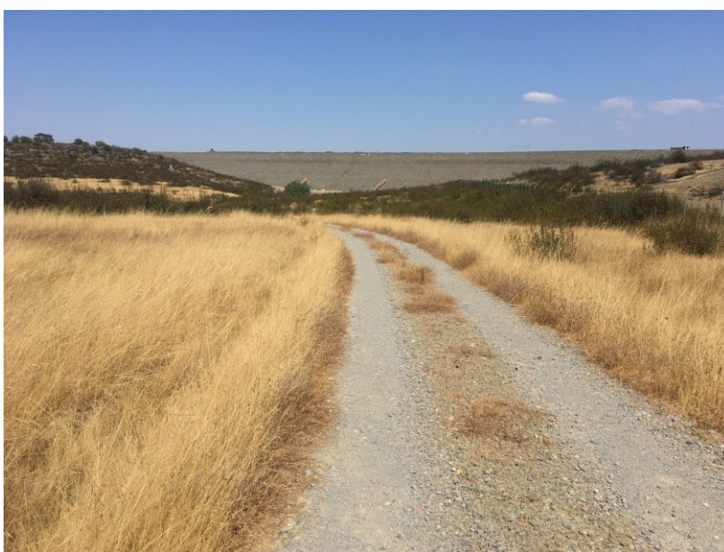
Fotografia 10 – Acesso a melhorar para novo canal de drenagem (a Este do RC-NW).
