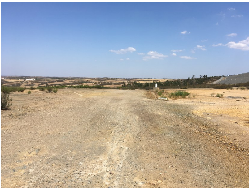
Fotografia 6 – Acesso a melhorar para RC-N.
