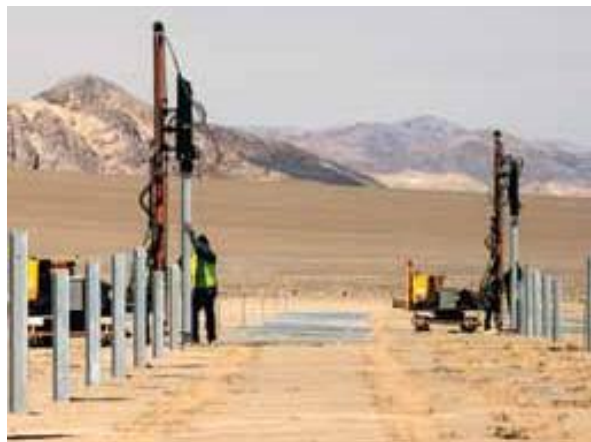
Figura 4.11 – Simplicidade de Instalação dos Parafusos de Fixação
