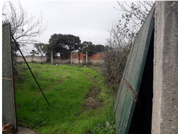
Figura 4. Local de entrada no estaleiro, onde será instalada fossa estanque
