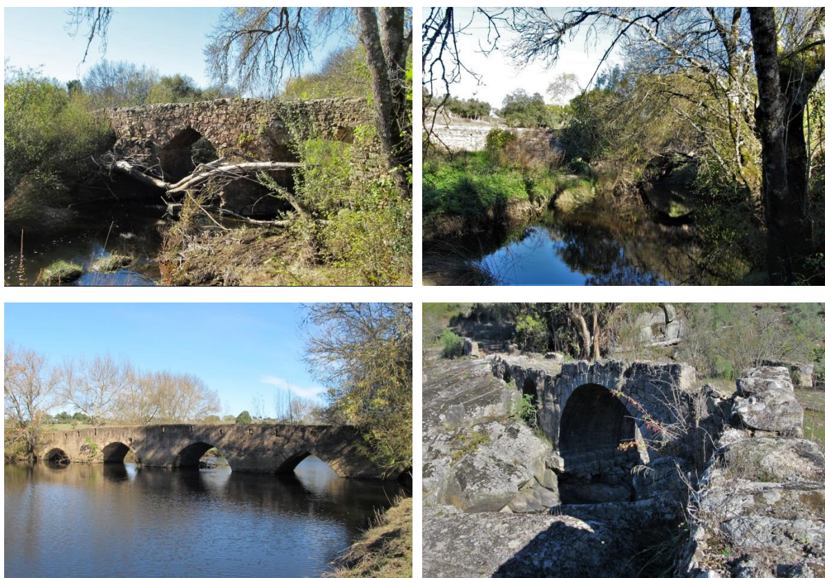
Foto 8.4 – Pontes históricas da ribeira de Seda: Ponte Velha dos Prados, Ponte do Caminho dos Prados, Ponte do Chocanal e Ponte de DeCosta.
