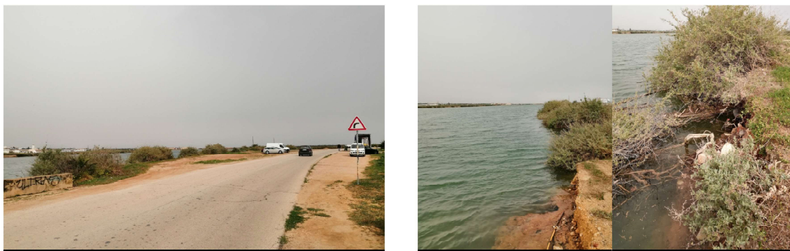
Ilustração 3: Vistas gerais: Estrada das Quatro Águas / Frente ribeirinha / taludes na margem do rio Gilao
