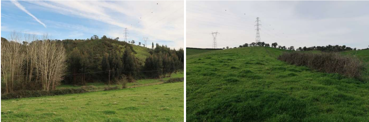
Fotografia 1.3 e 1.4 – Vista do apoio 9 para sul, em direção ao relevo do apoio 8 e corredor a partir de sul, com vista para o futuro acesso e local do apoio 9.
