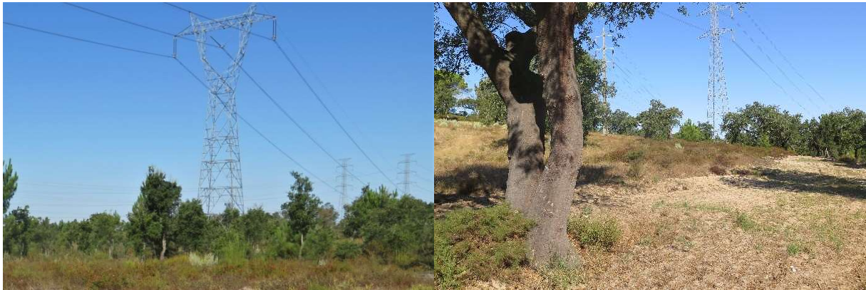
Fotografia 1.19 e 1.20 – Troço final do corredor de linha apoios 65 e 68, nas imediações da Quinta da Ortiga.
