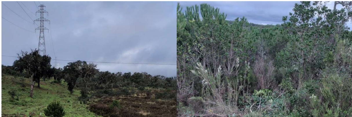
Fotografia 1.10 e 1.11 – Vista no corredor nas imediações do apoio 27 e do apoio 29.
