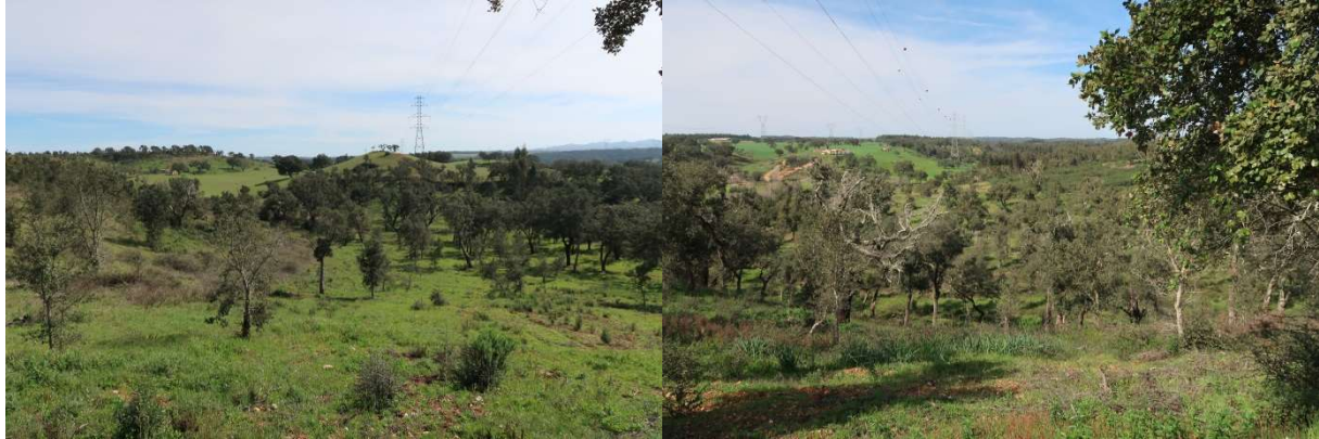
Fotografia 1.8 e 1.9 – Vista de norte para o corredor na zona do apoio 21 e vista do apoio 22 em direção a norte.
