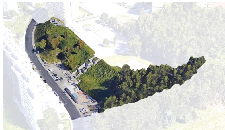
Figura 3.32 - Vista do local de implantação da futura Estação de Vila d'Este (Fonte: GoogleMaps)
