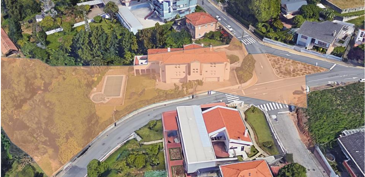
Figura 3.15 - Área de afetação na zona de transição entre o Viaduto de Santo Ovídio e o emboquilhamento poente do túnel localizado também na Quinta Cavadas (Fonte: Google Earth)
