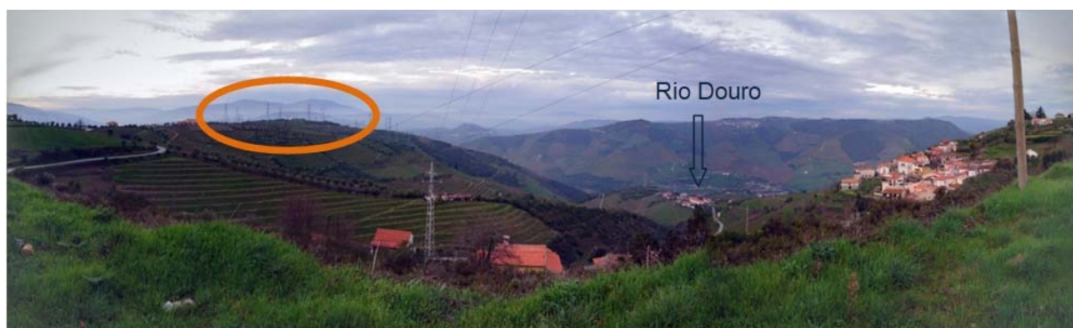
Fotografia 1 – Localização da Subestação de Valdigue
