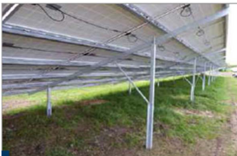
Figura 5 – Solução da estrutura para 6 módulos em posição paisagem
