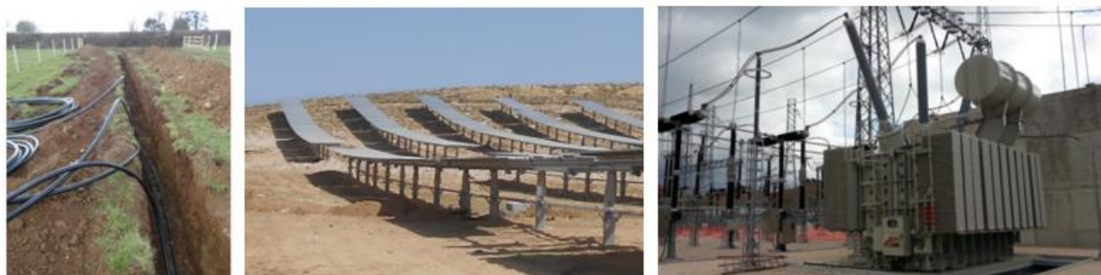
Figura 7 - Momentos da fase de construção da central.
