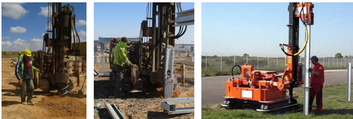
Figura 13 – Processo instalação perfis principais.
