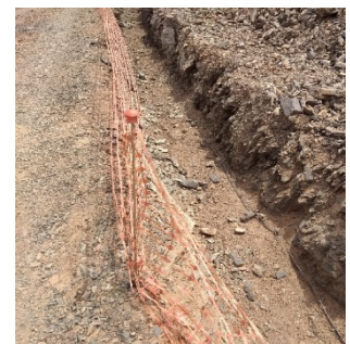
Exemplo da abertura da vala para cabos elétricos
