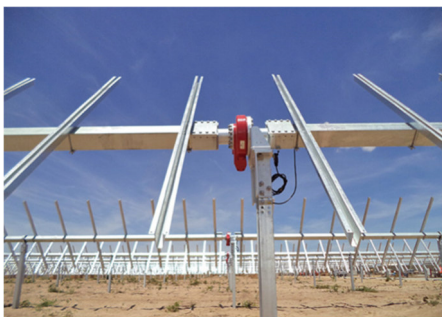
Terreno preparado com estruturas metálicas para suporte de seguidores solares de um eixo
