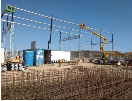
Exemplo da obra da subestação numa Central Solar Fotovoltaica
