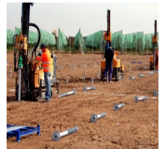
Perfuração do solo para execução da fundação da estrutura
