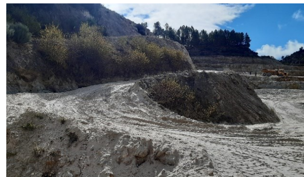
3 - Pormenor da área de lavra e talude revegetado
