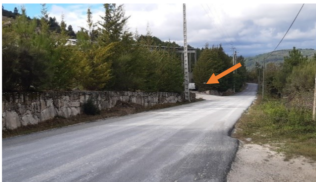
1 - Entrada para a mina Vila Seca
