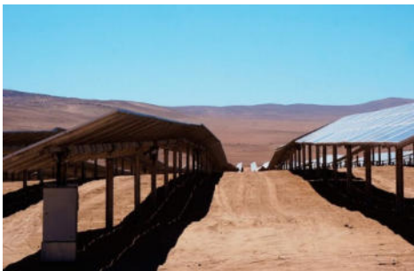
Exemplo de uma Central Solar Fotovoltaica com módulos que acompanham o relevo
