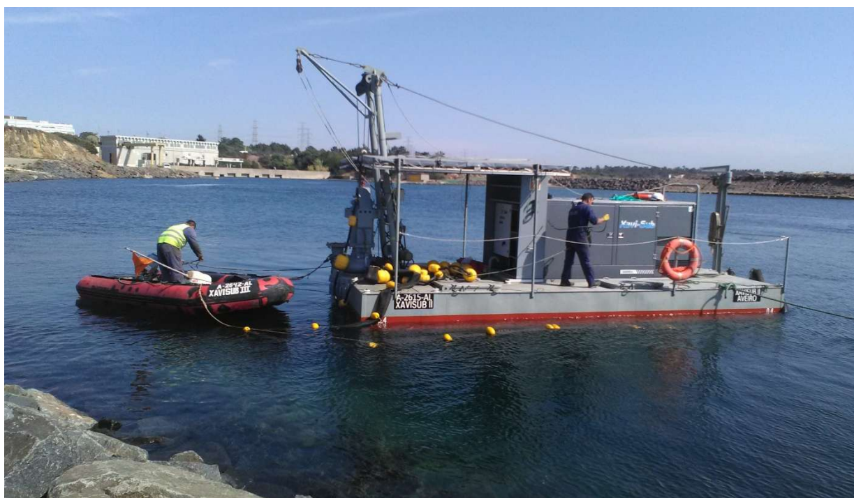
FIG. 2 – Plataforma de dragagens Xavisub II, usada em dragagens de injeção de água
