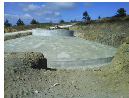
Fundação betonada e pronta para ser aterrada
