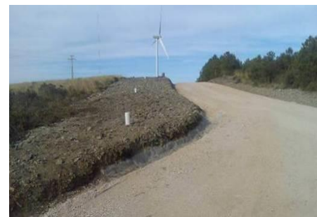
Vala de Cabos após recuperação paisagística
