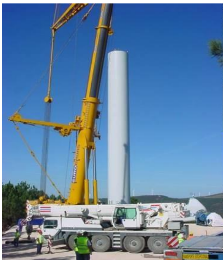
Plataforma de montagem do aerogerador
