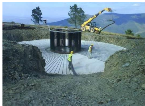
Trabalhos de armação de ferro
