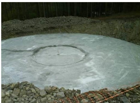
Fundação com betão de limpeza
