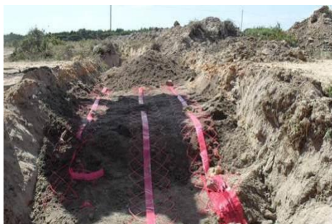
Colocação da Rede de sinalização vermelha
