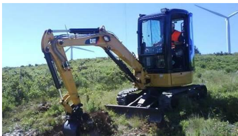
Trabalhos de Escavação da Vala
