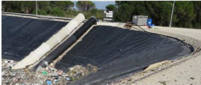
Figura 7-2 – Extração de lixiviados por bombagem na Fase B
