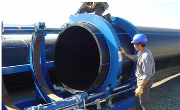
Ilustração 8. Processo da soldadura das tubagens PEAD.
