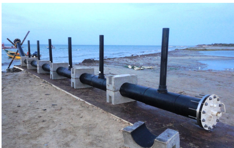
Ilustração 12. Exemplo da montagem do tramo difusor em terra com os lastros.
