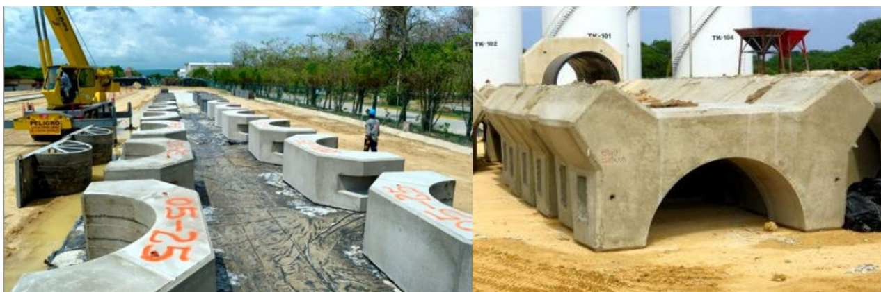
Ilustração 9. Exemplo dos locais de fabrico e armazenagem dos lastros.
