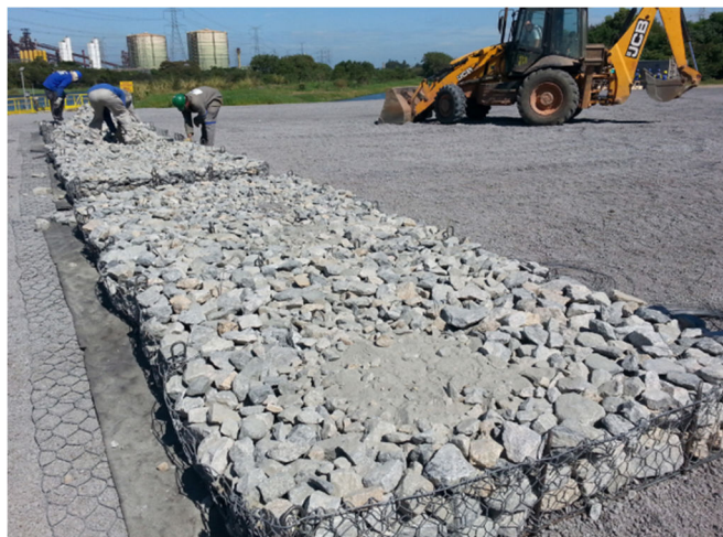
Ilustração 24. Proteção contra a erosão
