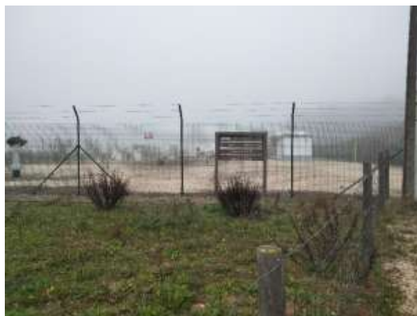
Fotografia 6.8 – Estação de Regulação de Pressão e Medição da Abrigada (GRMS 1319)
