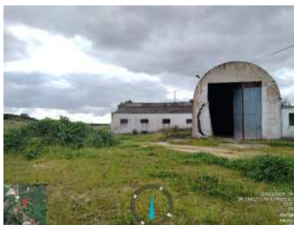
Fotografia 6.36 – Edificações em estado de abandono dentro da Área de Estudo [2]
