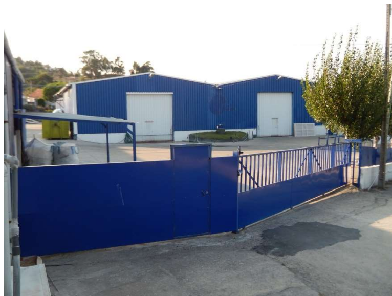
Figura 3 – Edific. 3 – Lacagem – Entrada da Instalação
