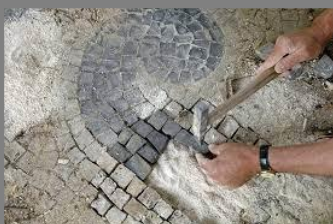
Pavimentação em calçada
