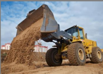
Movimento de maquinaria e escavações
